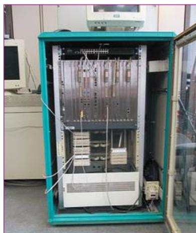
Рис. 3. Корзина MSAN на 20 платомест
