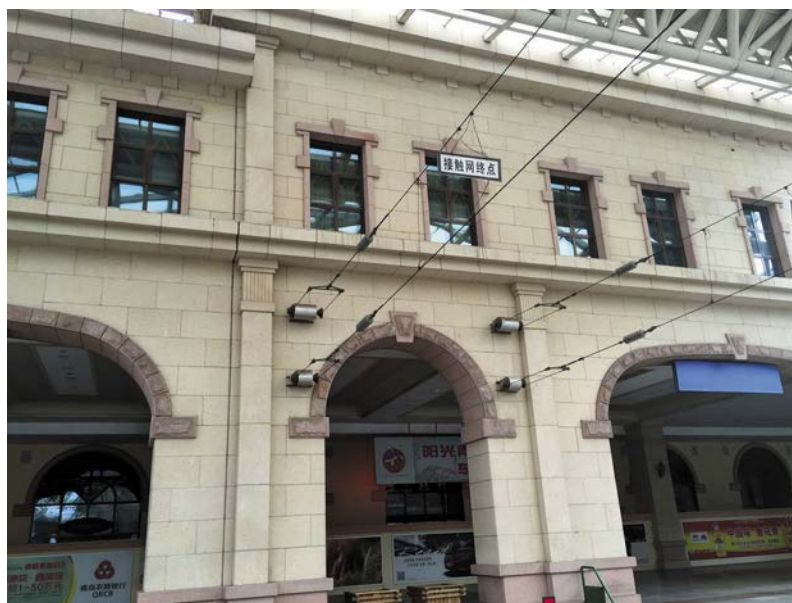
Рис. 2. Установка пружинных компенсаторов DFHTB в КНР
